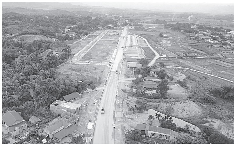
Tỉnh lộ 166 được đầu tư nâng cấp sẽ tạo điều kiện thuận lợi cho giao thương, thu hút đầu tư.
